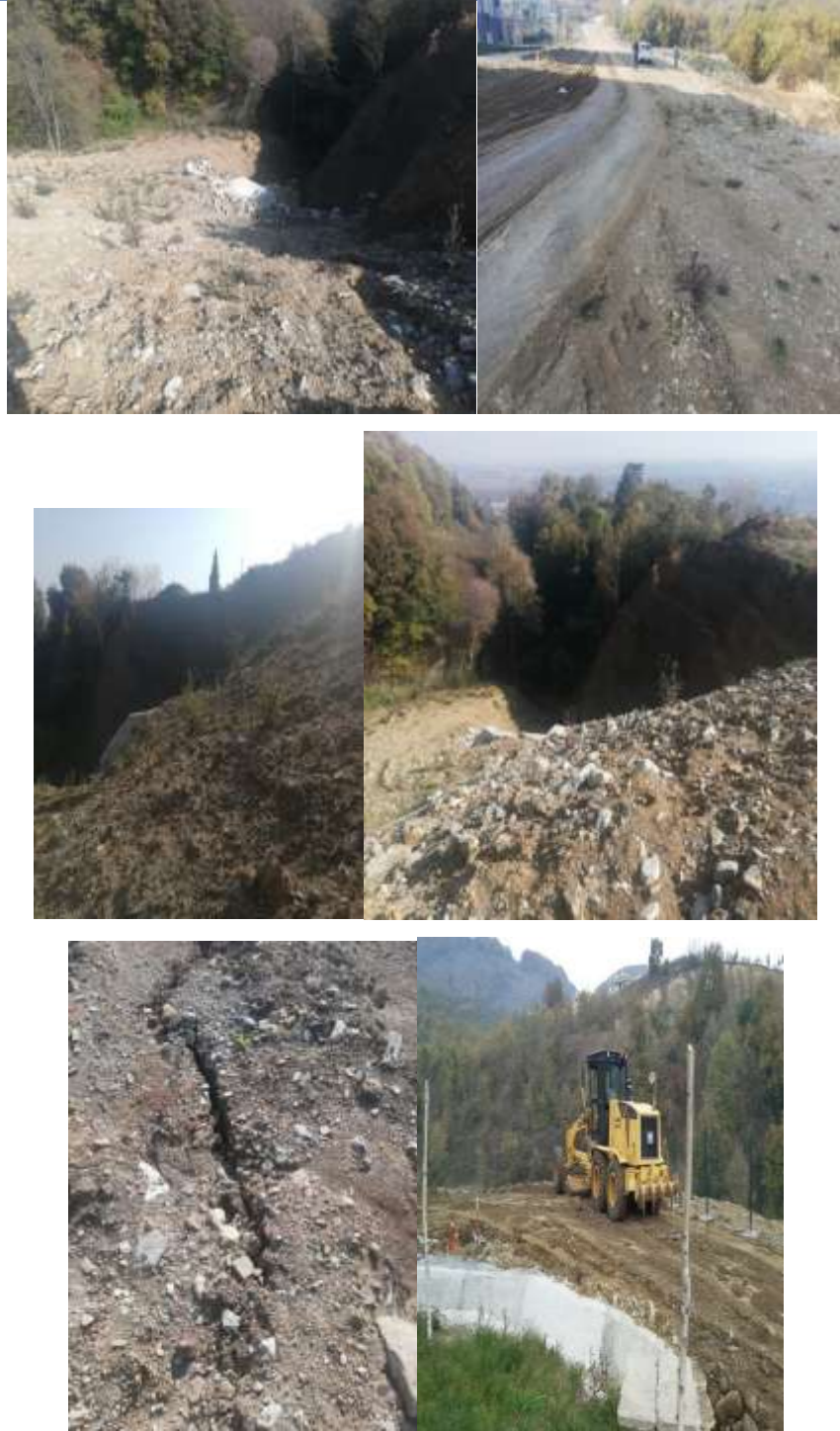
Şekil 3. Çalışma Alanından Görünüm
