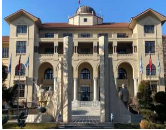
Şekil 2. Rektörlük Binası Giriş Merdivenleri (Beytaş, 2025)
