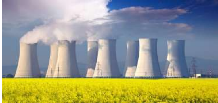
Şekil. 2. Soğutma kuleleri, Leningrad Nükleer Santrali
