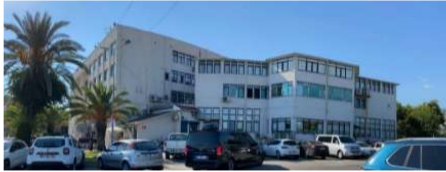
Güneydoğu Cephesi (İsmailoğlu, 2022)
