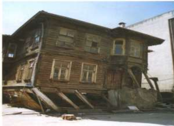
Şekil 4: 17 Ağustos 1999 depreminde Adapazarı'nda yıkılış karkas yapı (Bayülke, 2001).
