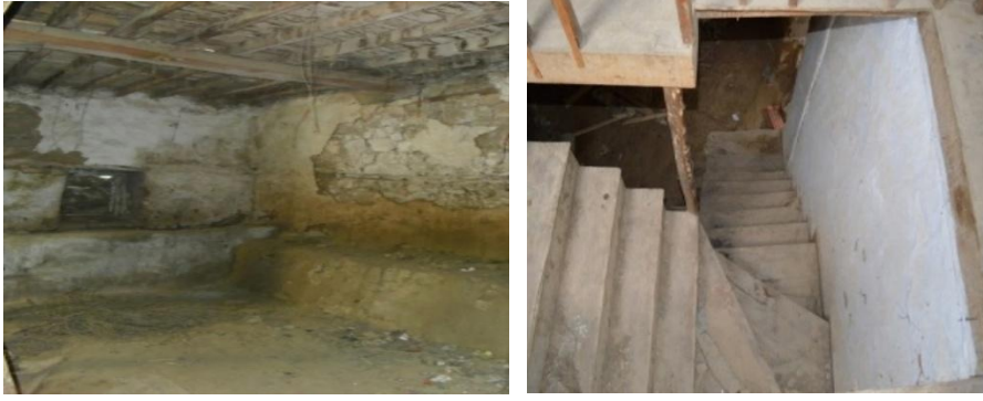
Şekil 26. Zemin katta yer alan bir depo alanı, katlar arası bağlantıyı sağlayan bir merdiven
