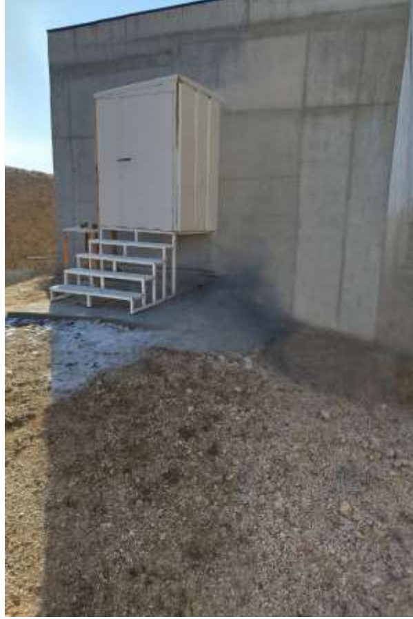
Şekil 6. Betonarme kapalı patlatma test odası
