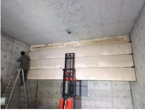
Şekil 7. Tavandan tabana duvar örüm işlemi
