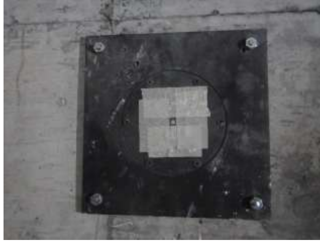
Şekil 9. Duvarın önden görünüşü
