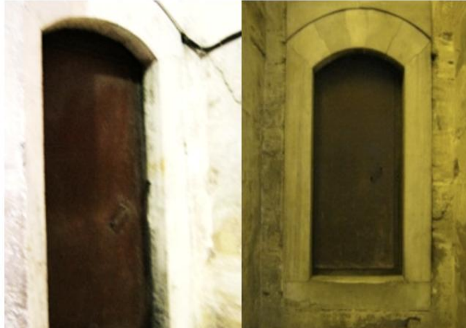
Şekil 3.14. ve Şekil 3.15. Ayasofya minarelerinin kuzey ve güney yan duvarlarındaki kapılar (Bilgen, 2011)
