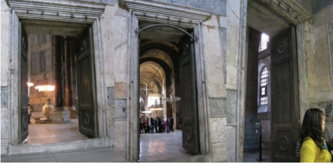
Şekil 3.19., Şekil 3.20. ve Şekil 3.21. Narteksten naosa açılan üç kapı (halk için), (Bilgen, 2011)
