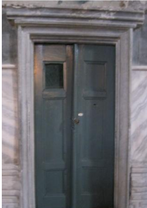
Şekil 3.63. Ayasofya'nın Naos mekânında doğu yan duvarındaki küçük koridorun kapısı, (Bilgen, 2011)
