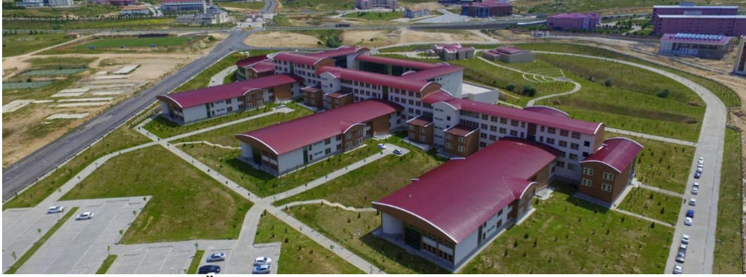
Fotoğraf 1: Yozgat Bozok Üniversitesi Müh. Mim. Fakülte Binası
