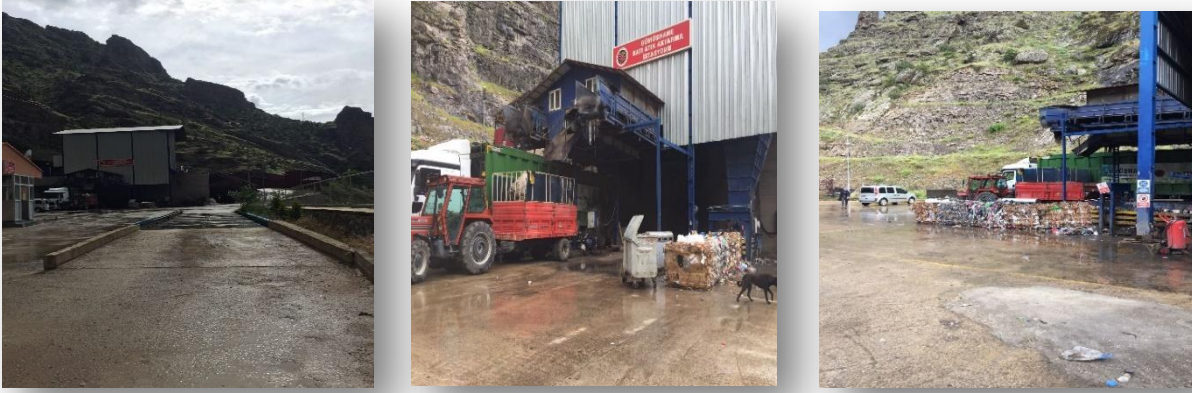
Şekil 1 : Gümüşhane Katı Atık Tesisi
