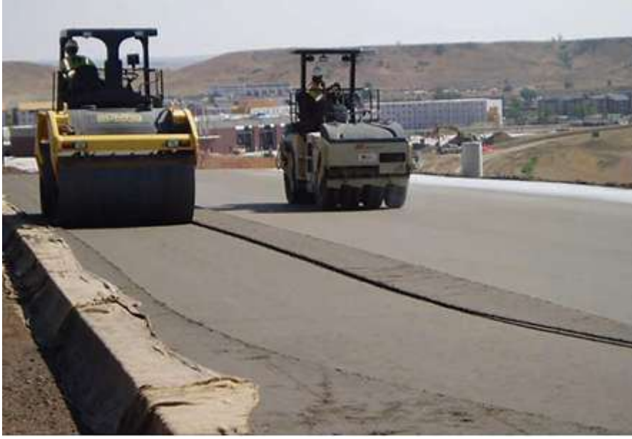
Şekil 2. SSB silindirle sıkıştırma işlemi (Savaş 2019)
