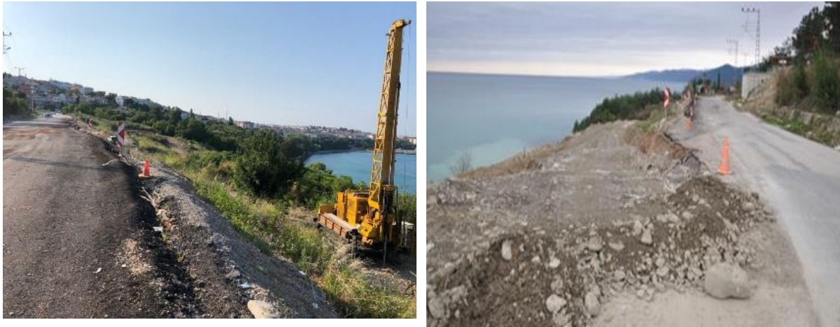
Şekil 8. Alanda yapılan fore kazık çalışmalarına ait görüntüler (Url-3)
