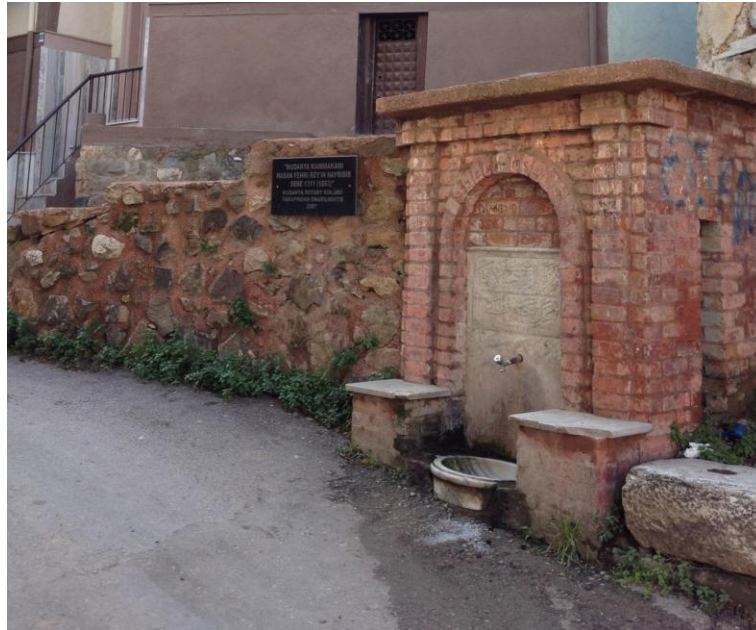
Şekil 3.8. Hasan Fehmi Bey Çeşmesi (Güner, 2013)
