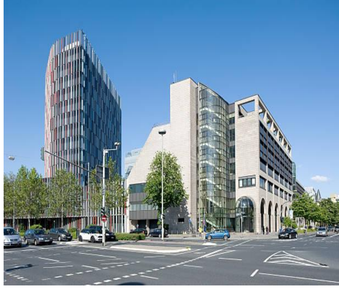
Şekil 4.1.2 KfW Binası (URL-2)
