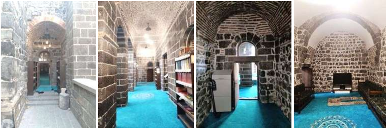
Şekil 7. Zinciriye Medresesinde tuğla- taş malzeme kullanım alanları (2025)
