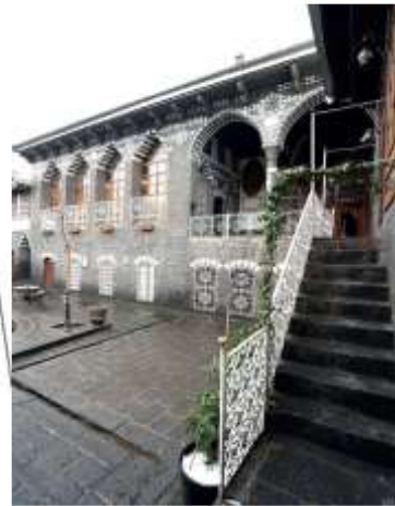
Şekil 3. Diyarbakır geleneksel ev örneği (Cahit Sıtkı Tarancı Evi)
