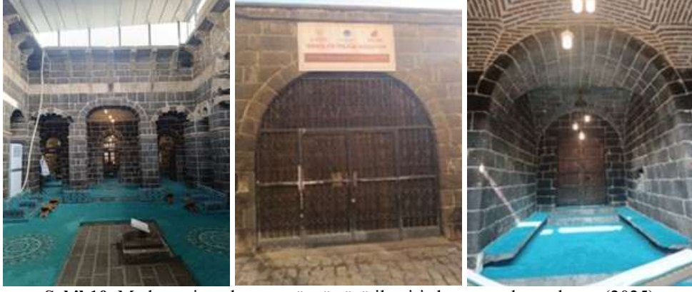
Şekil 10. Medresenin avlusunun üst örtüsü ile giriş kapısının kapatılması (2025)
