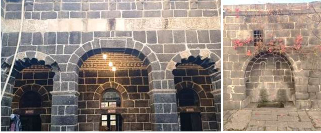
Şekil 12. Medrese cephesindeki taş malzemede yüzey kirliliği ve bozulmalar (2025)
