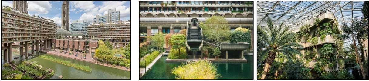
Şekil 1. Barbican Center'a Ait Görünümler
