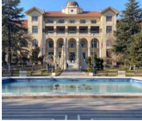
Şekil 1. Gazi Üniversitesi Rektörlük Binası (Beytaş, 2025)
