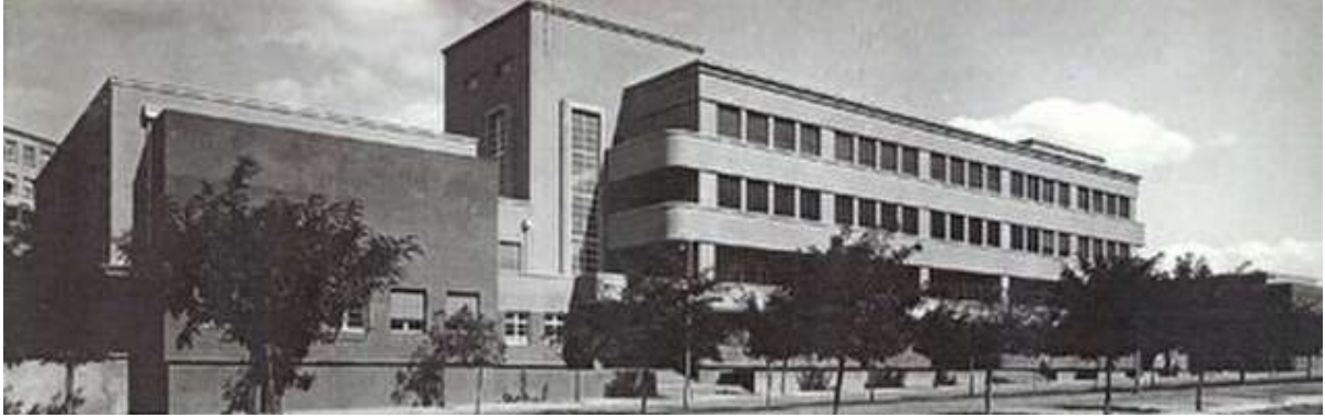
Şekil 3. Giriş Cephesi (Kültür Envanteri, 2024)
