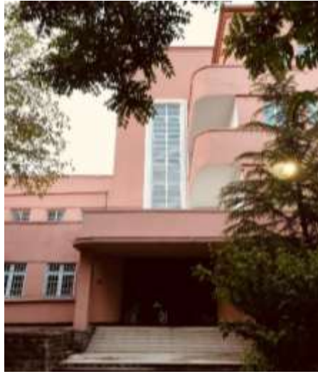
Şekil 4. Giriş Cephesi Görüntüsü (Kültür Envanteri, 2024)
