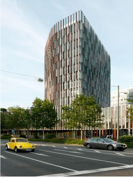
Şekil 4.1.1 KfW Binası (URL-1)
