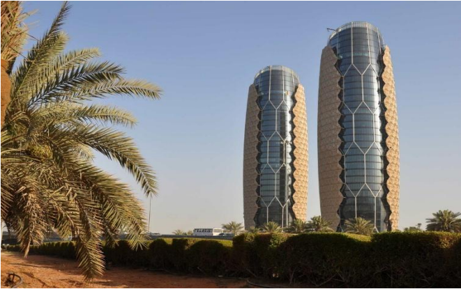
Şekil 4.2.1 Al Bahar Towers Binası (URL-3)
