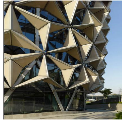
Şekil 4.2.2 Al Bahar Towers Binası Cephe Sistemi (URL-4)
