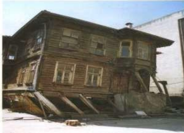
Şekil 4: 17 Ağustos 1999 depreminde Adapazarı'nda yıkılış karkas yapı (Bayülke, 2001).
