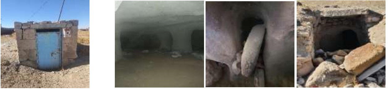
Şekil 2.4 Şehir Giriş Kapısı Örneği A), Şehir İç Mekanı B), Şehir Güvenlik Kapısı C), Şehirde Çökme Örneği D)
