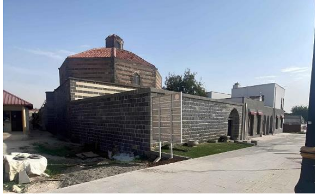
Şekil-8. Behram Paşa Hamamı Kuzeybatı Cephesi
