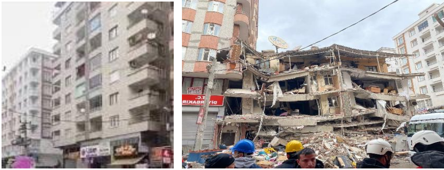
Şekil 2.2. Yenişehir ilçesinde yıkılan Sözel Apartmanının deprem öncesi ve sonrası durumu (URL 2)
