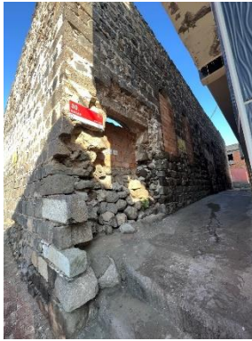
Şekil 3.7 Kuzey cepheden görünüm
