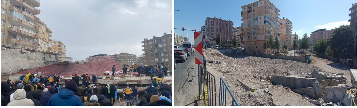
Şekil 2.4. Bağlar ilçesinde yıkılan Serin 2 Apartmanının deprem sonrası durumu (2023)
