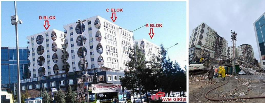
Şekil 2.1. Yenişehir ilçesindeki Galeria Sitesinin deprem öncesi ve sonrası durumu (URL 1)
